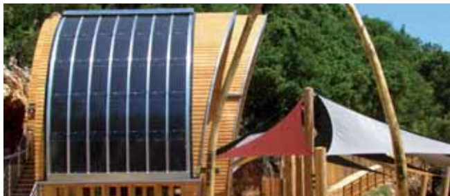
L'ingresso della grotta di Salamandre, in Francia, è stato realizzato utilizzando i pannelli in policarbonato Lexan di Sabic
