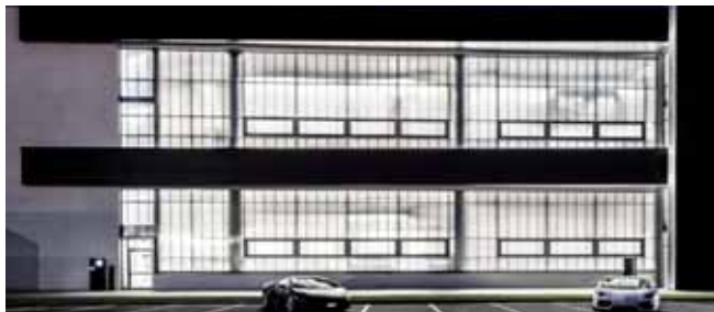
Protoshop di Lamborghini è il primo edificio industriale multipiano ad aver ottenuto in Italia la certificazione di Classe A per il risparmio energetico
