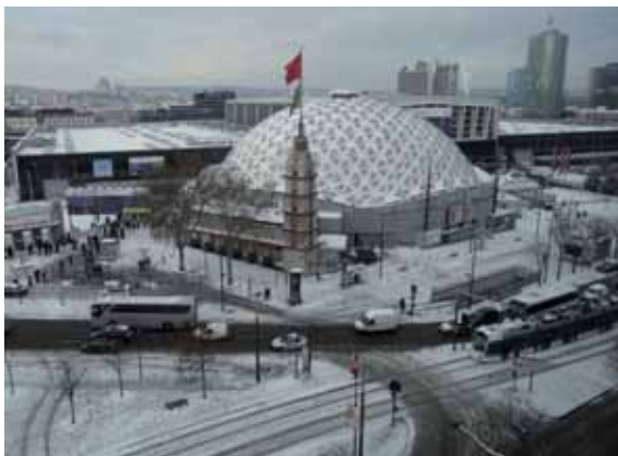
JEC Composites 2013 ha segnato anche un nuovo record: la bufera di neve che ha imperversato nel nord della Francia; fenomeno rarissimo in primavera
