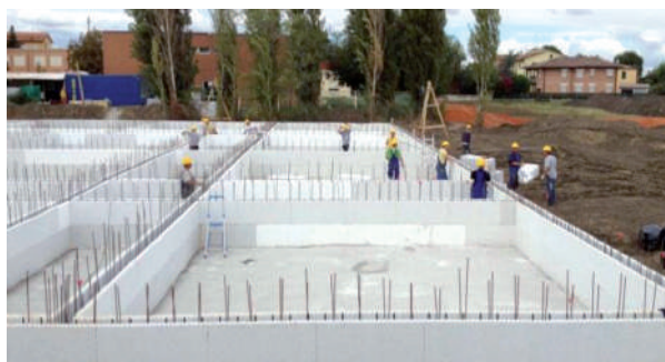
La ricostruzione della scuola di Poggio Renatico, Ferrara, con criteri antisismici, di basso consumo energetico e di elevato isolamento acustico (Foto: Consorzio ICF Italia)
