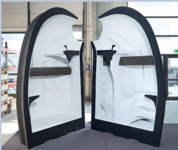
La casa stampata in 3D, del peso di appena due tonnellate, soddisfa tutti i requisiti imposti dall'architetto Peter Ebner, che dal canto suo si è dichiarato entusiasta dell'esecuzione tecnica e della stabilità della stampa
