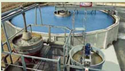
污水处理/回收系统, 以60-70立方米/小时的能力, 辅助1000至1200千克/小时的聚丙烯大袋和百塑烯(LDPE)薄膜回收生产线
